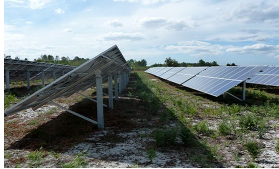
Figure 40 : Exemple de type de structure sur mono-pieux
